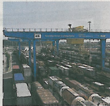
Das Kombiverkehrsterminal der BASF soll ausgebaut werden.
